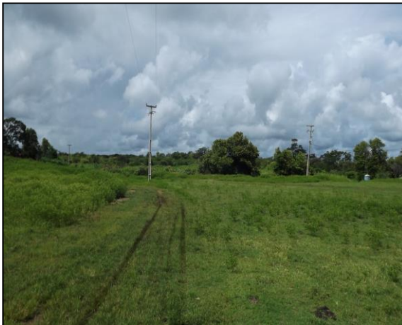
Foto 15 - Trecho de rede elétrica de baixa tensão em área que será inundada (UTM 357388/ 9526322)
