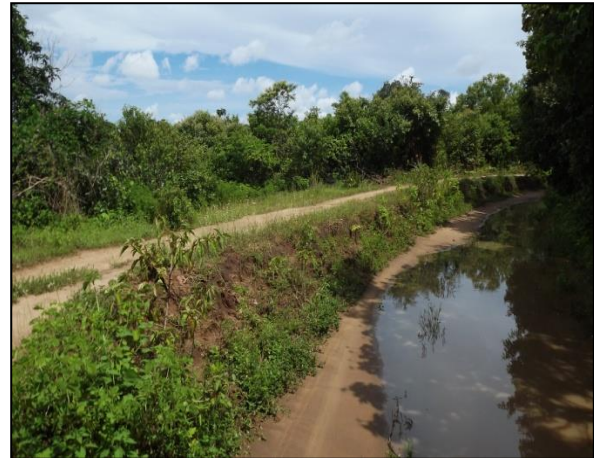
Foto 14 - Corte de estrada de acesso a área da bacia hidráulica da Barragem (UTM 352949/ 9530016)
